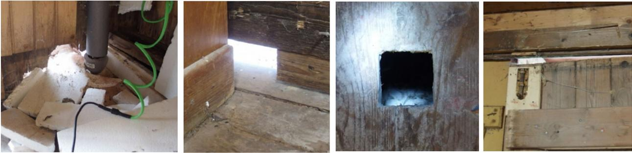
Abb. 12: Diverse Zugänge in das Gebäude über bodennahe kaputte Leisten der Außenfassade, Löcher im Fußboden und Spaltenbereichen über den Türen
