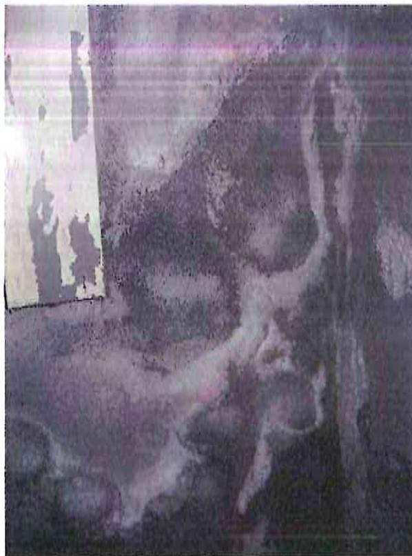
**Abbildung 7: Ausblühungen an der feuchten Kellerwand**
